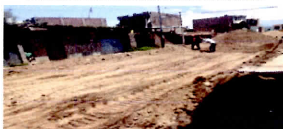
VISTA DEL PROYECTO EN EJECUCION
