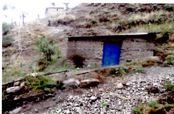
Intervención a extractores ilegales de agregados.
